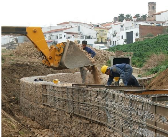
Preparación y cosido de la malla, encofrado de gaviones y vertido de piedra. Vertido de piedra, colocación cara vista de la piedra y colocación de tirantas
