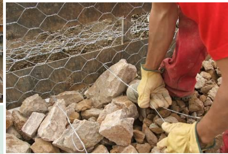
Preparación y cosido de la malla, encofrado de gaviones y vertido de piedra. Vertido de piedra, colocación cara vista de la piedra y colocación de tirantas
