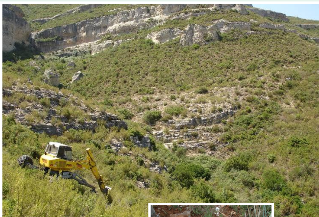
Ahoyados con miniretro de 9 tn y retroexcavadora de 30 tn, en zonas las zonas llanas y muy pedregosas
