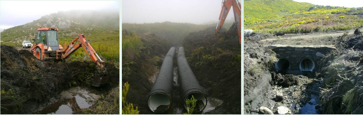
Construcción de pasos de agua de tubo corrugado
