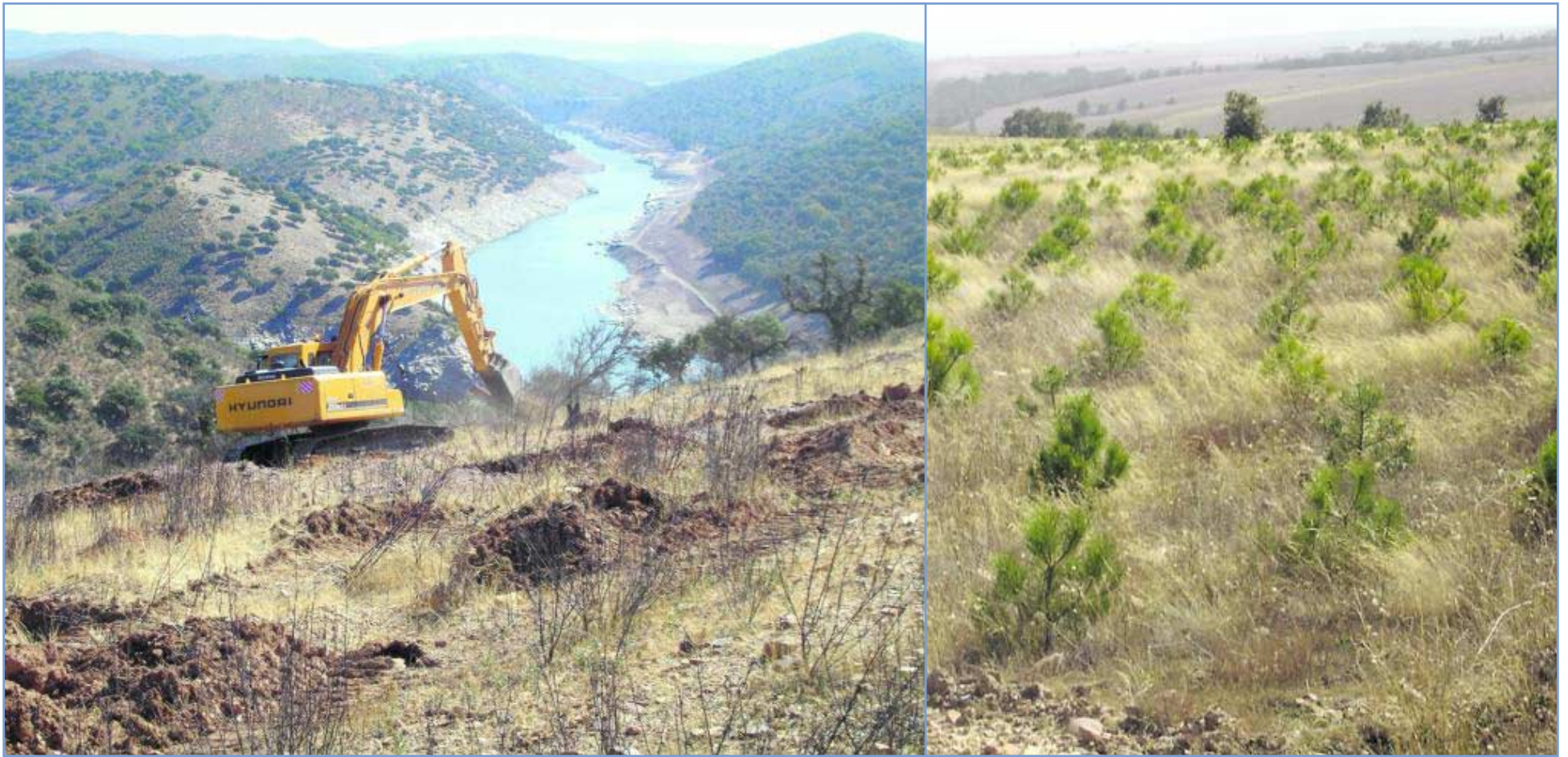
A la izquierda, una retroexcavadora trabaja en la ladera de un monte. A la derecha, una repoblación con pinos pendiente de su último mantenimiento. / FOTOS CEDIDAS POR FORESA
