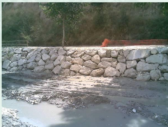
Las cañas fueron retiradas a zona de triturado para evitar contaminar más el cauce.
